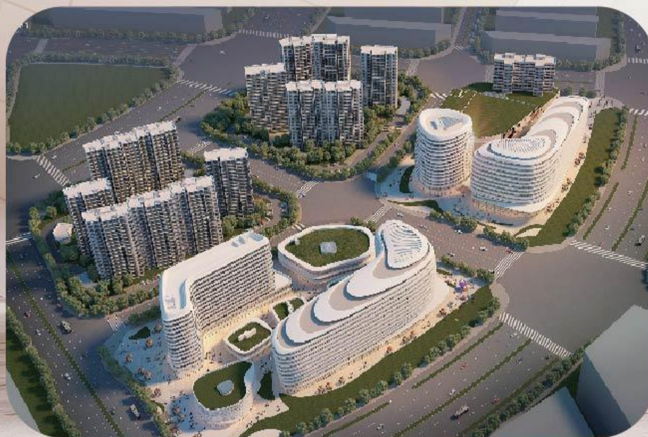
建业集团南阳凯旋工程二期
