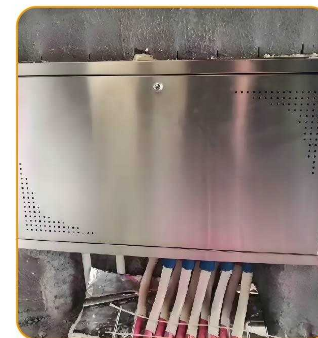
拉丝不锈钢分水器安装箱
